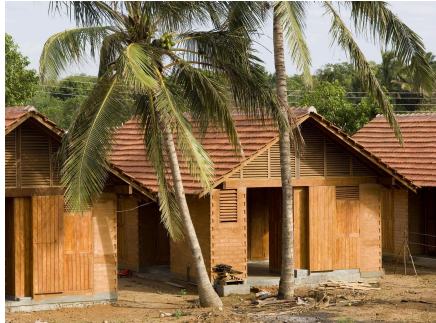
Figura 03 e 04: Utilização de Pré Moldado.
