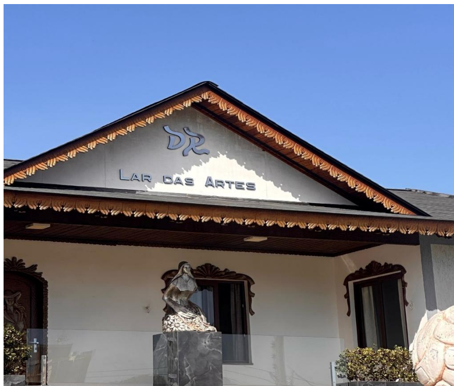
Fotografia 4 – Fachada do Lar das Artes, em Cascavel-PR
