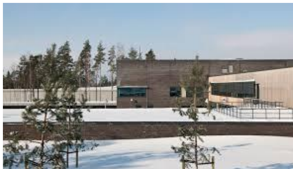
Figura 04: Halden Prison, vista bloco externo
