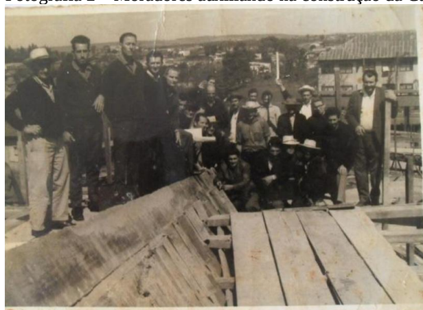
Fotografia 2 – Moradores auxiliando na construção da Catedral
