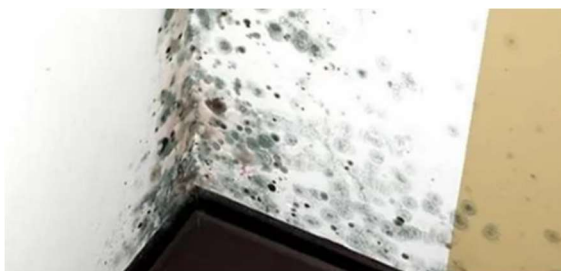
Figura 10: Bolor em superfície de revestimento.
