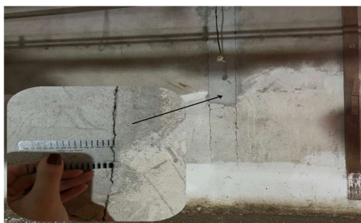
Figura 24: Trinca - 1,15 mm - Fundos Aviário 01. Figura 25: Trinca - 0,55 mm - Interno Aviário 02.
