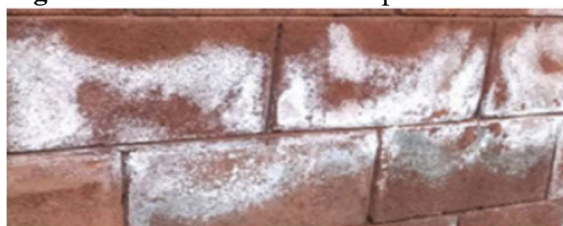
Figura 13: Eflorescência em superfície de revestimento.
