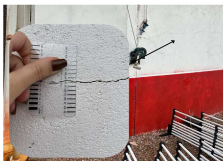
Figura 22: Fissura Horizontal - 0,45 mm - Frente Aviário 02.
