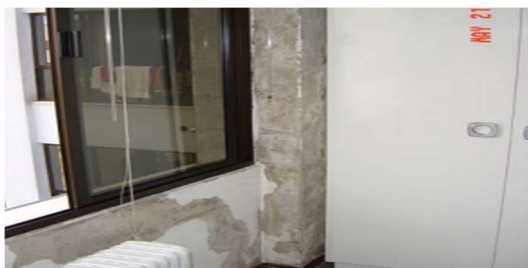
Figura 17: Desagregação de Argamassa.
