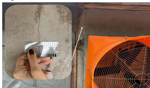
Figura 20: Fissura - 0,2 mm - Frente Aviário 01. Figura 21: Fissura - 0,35 mm – Lateral.
