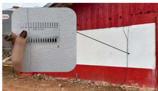
Figura 20: Fissura - 0,2 mm - Frente Aviário 01. Figura 21: Fissura - 0,35 mm – Lateral.
