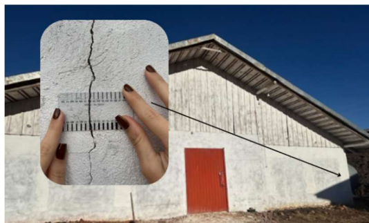
Figura 24: Trinca - 1,15 mm - Fundos Aviário 01. Figura 25: Trinca - 0,55 mm - Interno Aviário 02.
