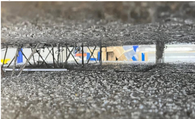
Figura 19 - Falha na ancoragem e embutimento de concreto na alça de içamento - cordoalha aparente.
