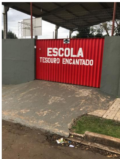
Figura 06: Rampa de entrada/saída da escola.
