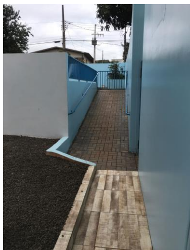
Figura 01: Rampa de acesso ao estacionamento.
