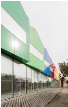
Figura 8 - Fundação Esther Koplowitz
