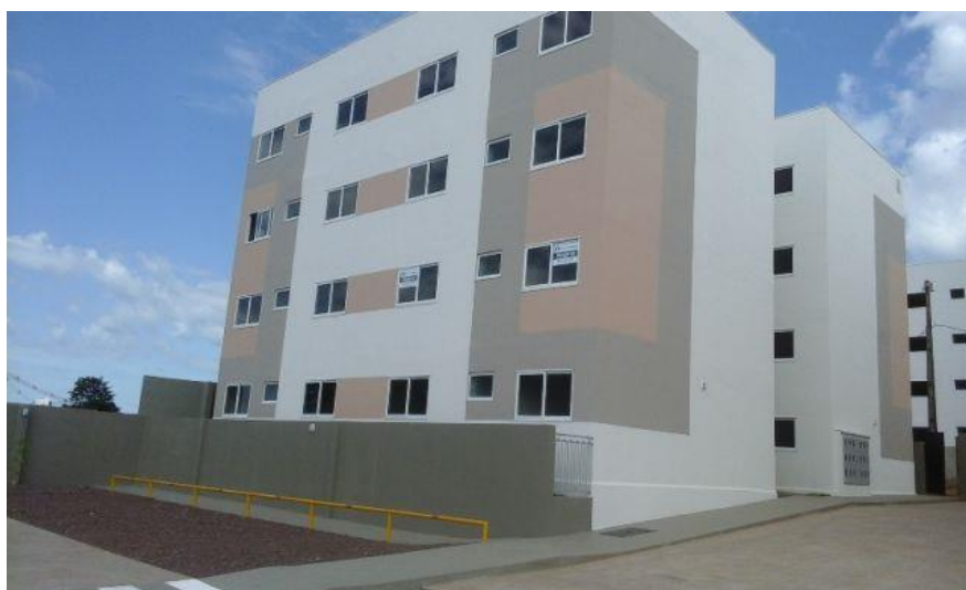
Figura 06: Faixada de um dos blocos do edifício.
