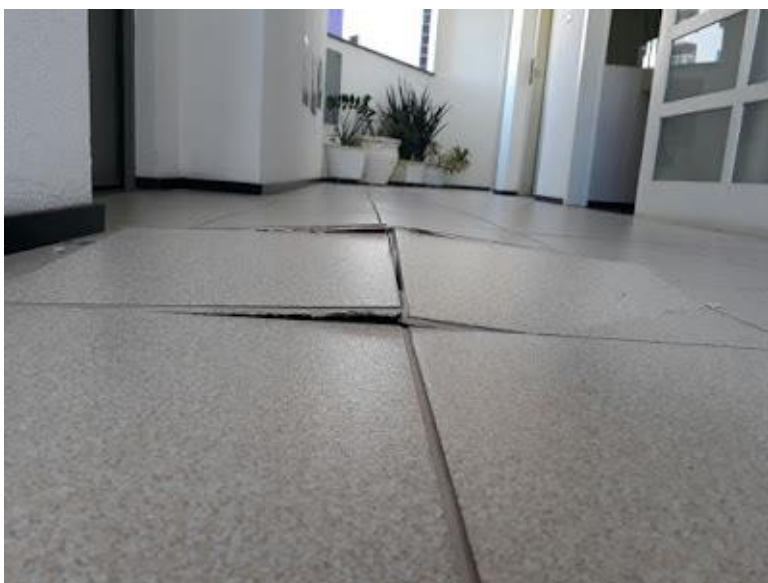
Figura 01: Descolamento cerâmico.
