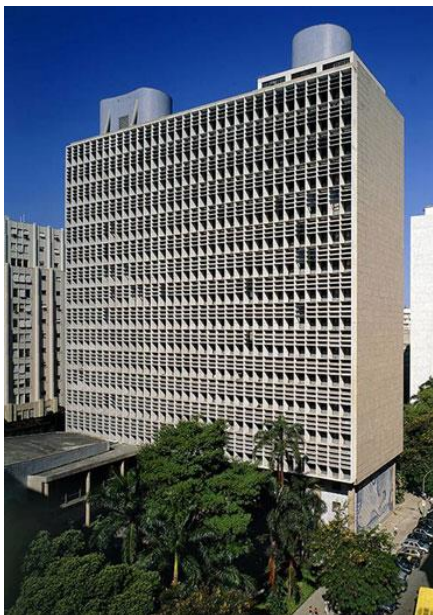
Figura 02 - Edifício do Ministério da Educação e Saúde Pública
