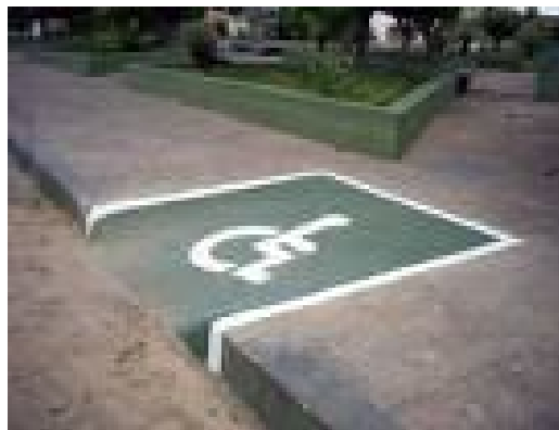
Figura 26: Calçada rebaixada Fonte: MOSTRA CASA - DECORAÇÃO (2009).
