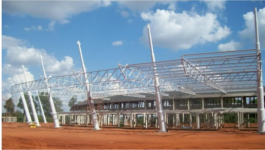
Figura 20: Estrutura metálica Fonte: WIKIPÉDIA, (2010)
