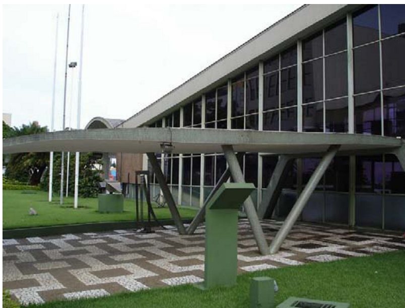
Figura 04 Entrada pela fachada sul. Fonte: PISANI; CORREA (2006)
