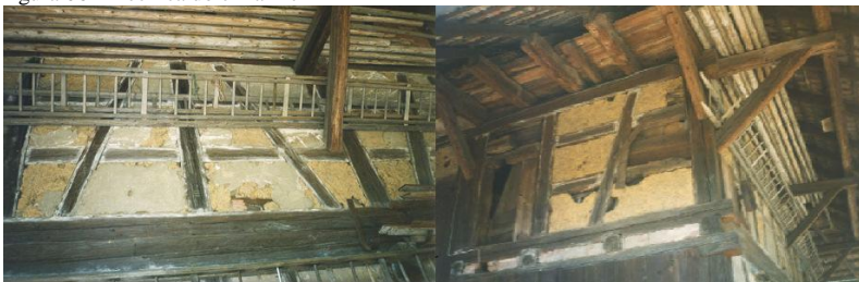
Figura 06 – Técnica do enxaimel
