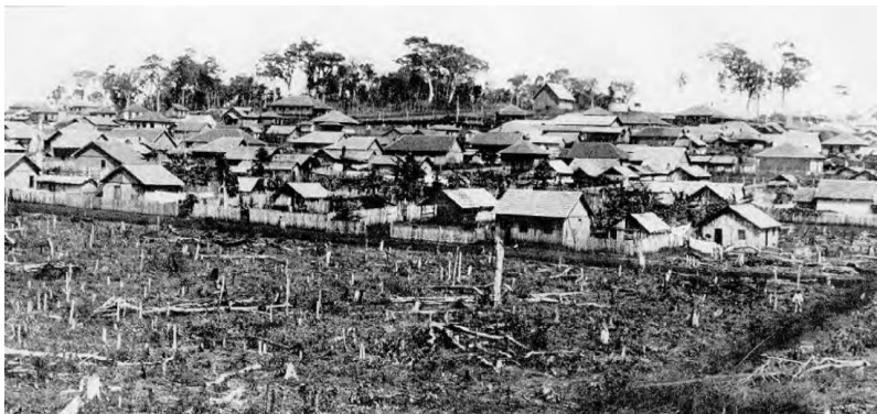
Figura 01 – Todas as edificações construídas em madeira
