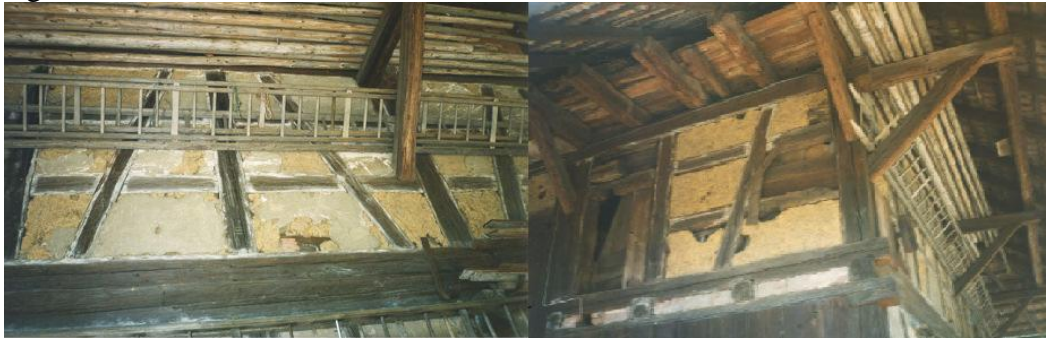
Figura 06 – Técnica do enxaimel
