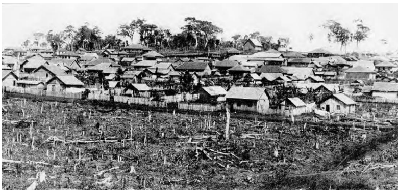
Figura 02 – Todas as edificações construídas em madeira
