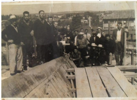
Figura 10 – Moradores auxiliando na construção da Catedral
