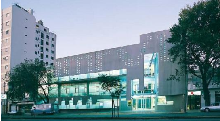
Figura 20 - Vista externa do instituto de reabilitação Vicente Lopes.
