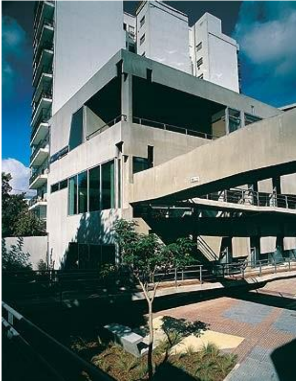
Figura 22 - Vista da estrutura em concreto armado.
