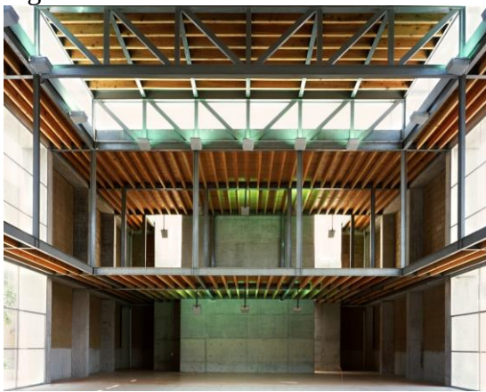
Figura 28 - Vista da estrutura em concreto armado, aço e vidro.
