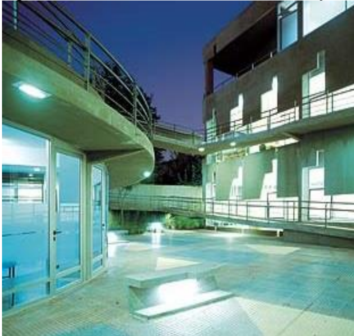
Figura 21 - Vista externa do instituto de reabilitação Vicente Lopes.
