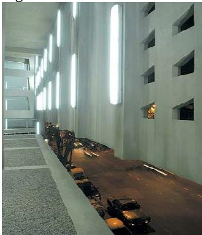
Figura 25 - Vista do Brise em concreto armado e perfurações que parecem janelas.
