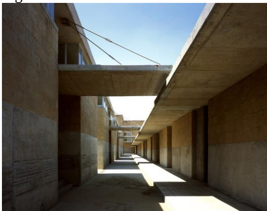
Figura 29 - Vista da estrutura em concreto armado, aço e vidro.
