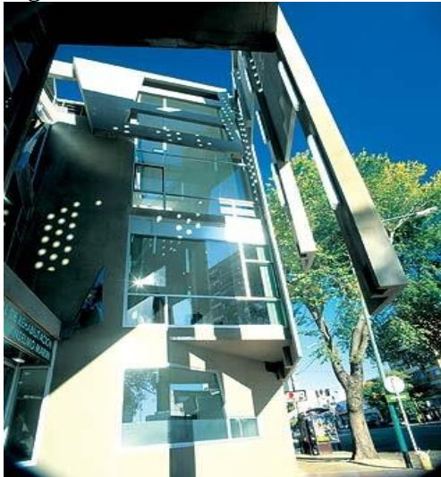
Figura 24 - Vista do Brise em concreto armado e perfurações que parecem janelas.
