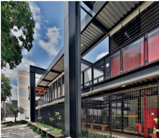
Figura 10 - Vista do corredor lateral e os elementos metálicos.
