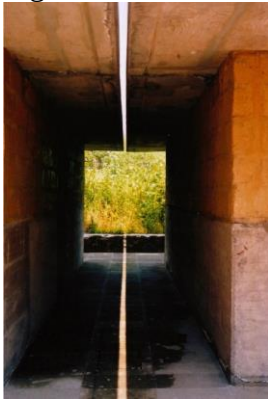
Figura 30 - Vista do canal de água, linhas verticais de concreto e plantas.
