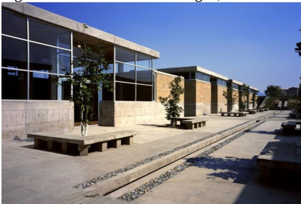
Figura 31 - Vista do canal de água, linhas verticais de concreto e plantas.
