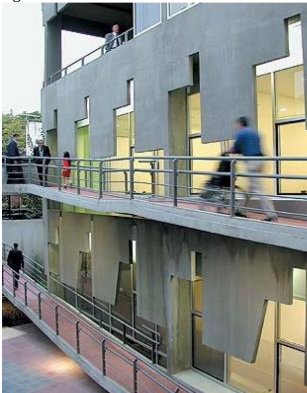
Figura 23 - Vista da estrutura em concreto armado.
