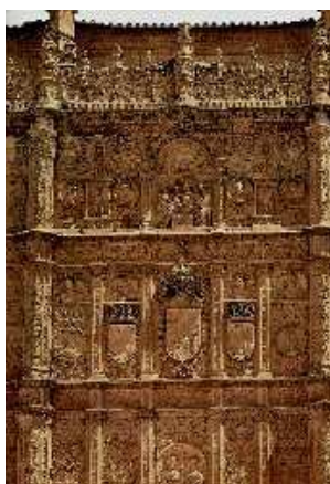
Universidade de Salamanca(fachada)
