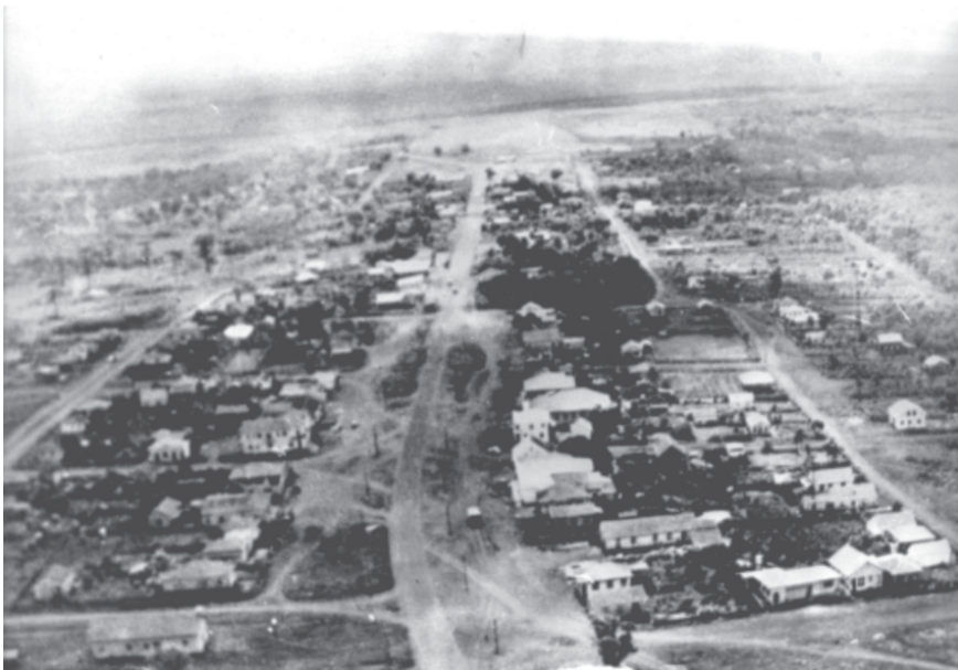
Figura 13: Patrimônio Novo abaixo e Patrimônio Velho aos fundos. Nota-se a diferença das proporções das quadras. A Rua divisora destes loteamentos era a então Rua Governador Lupion, hoje Rua 7 de Setembro. Avenida Brasil ao centro; Rua Paraná à direita e Rua Rio Grande do Sul à esquerda. Vista do atual centro em direção à Igreja Santo Antônio. 1957.
